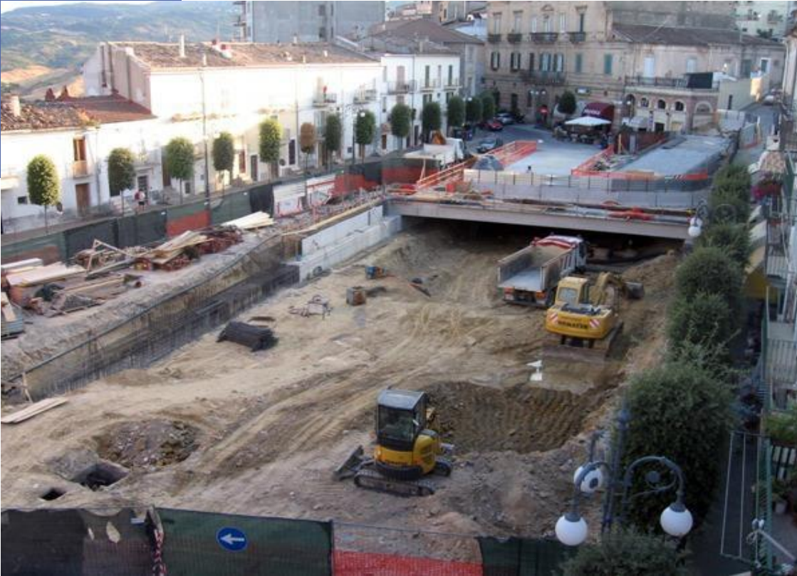
Parcheggio Interrato e residenze Piazza - Atessa
